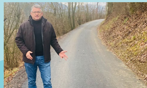
Sanierung Fahrbahn Dellacherweg inklusive Hangsicherung und Verlegung Wasserleitung
