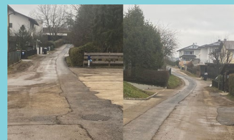
Beginn Großprojekt Wasser-/Kanal-/Oberflächenentwässerung/ Fahrbahnsanierung St. Peter a. Anger
