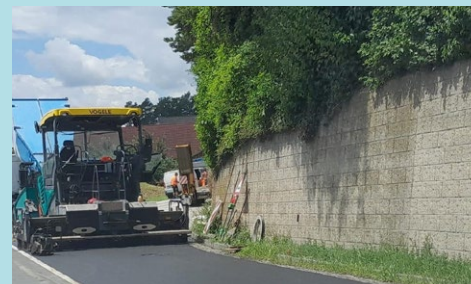
Sanierung Fahrbahn B82 Reipersdorf mit gleichzeitiger Leitungssanierung (Kostenanteil Gemeinde St.Georgen)
