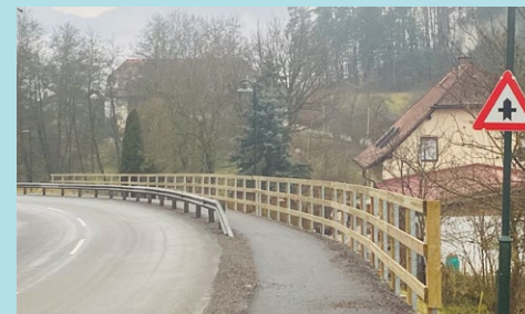
Sanierung Gehweg Teilstück L 83 Fiming
